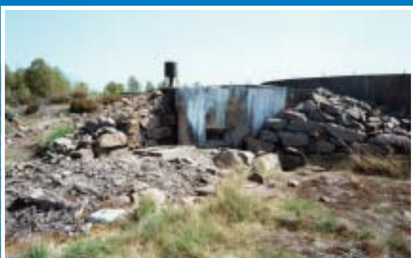
Minstationen på Inlängan (IL)
