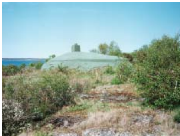
Minstationen Östra Hästholmen (ÖH)
