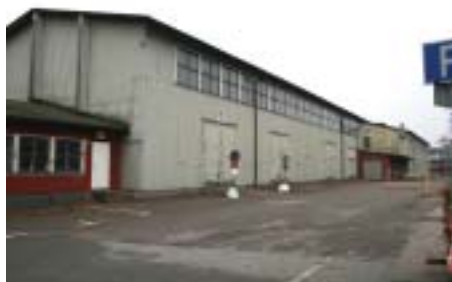
Artillerihallen före rivning
